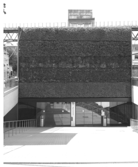
Mur Façade Est (largeur : 12,608 m)
