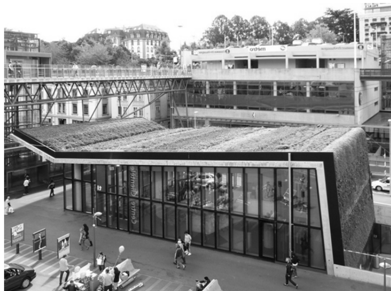
Vue aérienne de la gare
