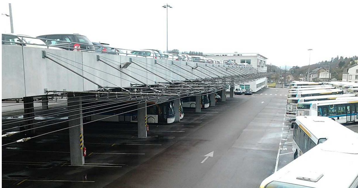
Figure 5 : vue d'ensemble de la gare de dépôt des trolleybus
