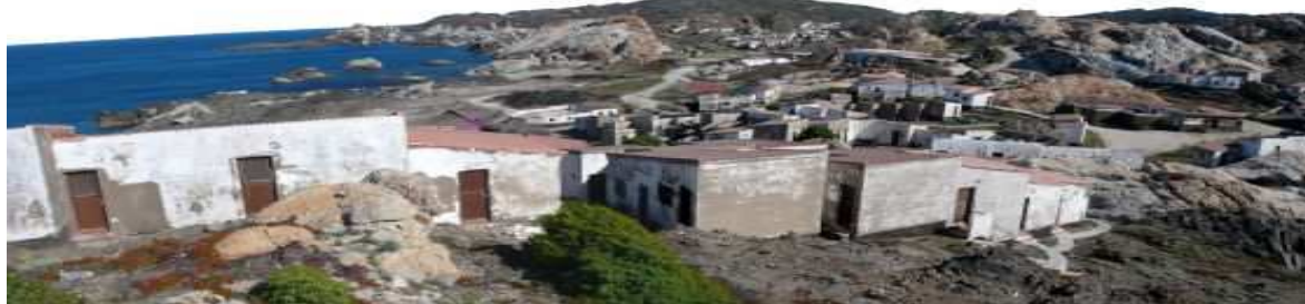
Los bungalós del Club Med antes de su deconstrucción.
