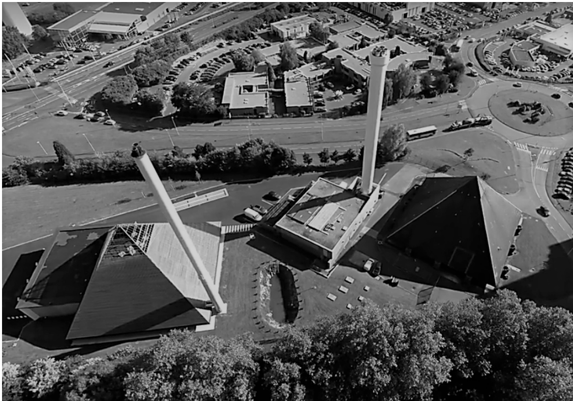
Figure 1 : chaufferie urbaine de Mons-en-Barœul
