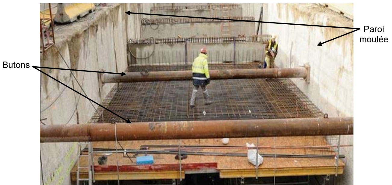
Exemple de butonnage d'une paroi (le moniteur)
