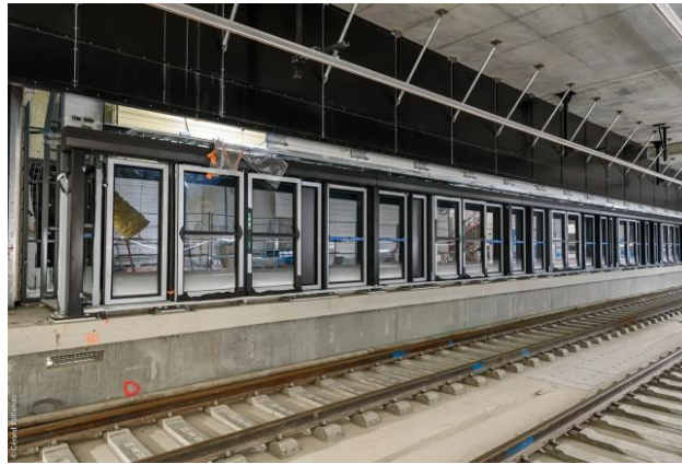
Vue de la façade de quai depuis les voies
